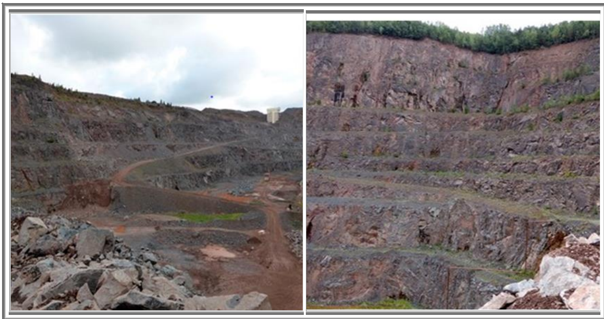
Figure 21 : Vosges : Vues de la carrière de trapp de Raon l'Étape
