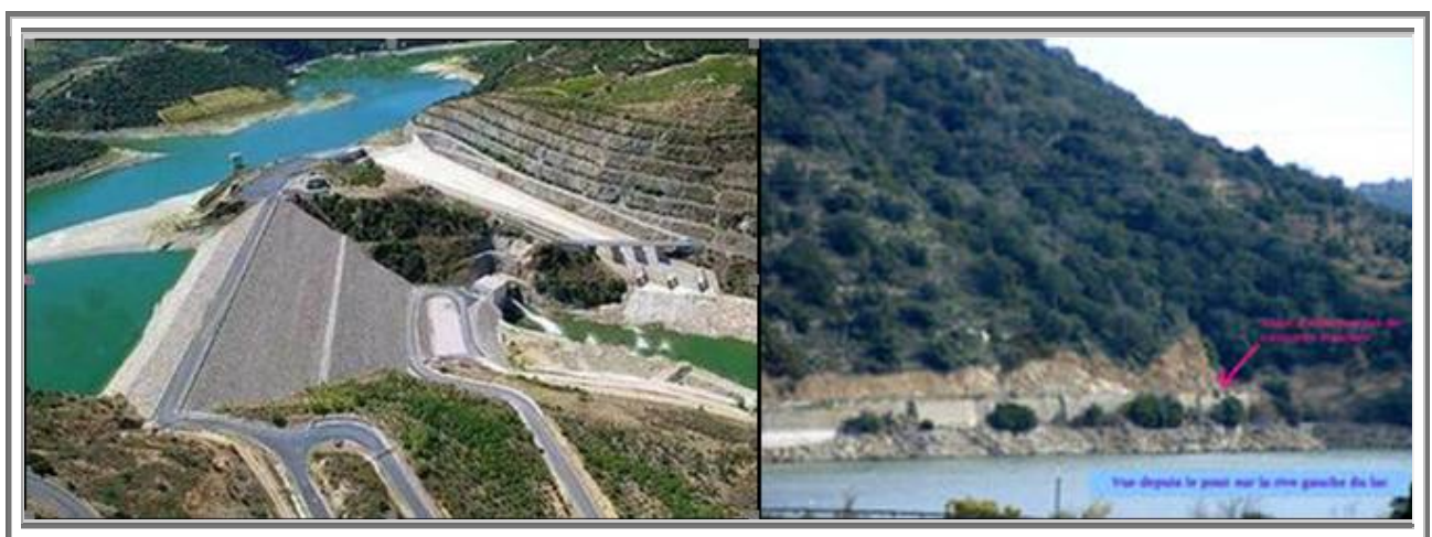
Figure 613 : PO66 : Caramany : Barrage de Caramany Figure 614 : PO66 : Caramany : Pont sur Agly : gneiss à grenats (lithothèque)
