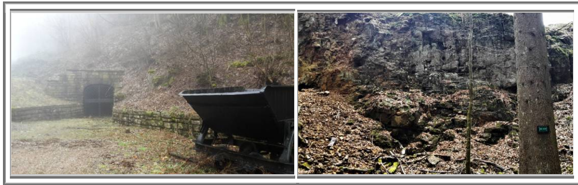
Figure 711 : Vosges : Vues sur la mine de Grand fontaine et la mine jaune
